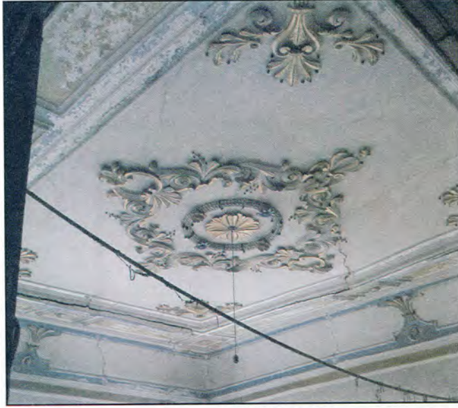
Şekil 3.148. Alçı kabartma üzerine yapılan renklendirme-Sarıoğlu Evi(Burdur Kültür Ve Turizm Müdürlüğü fotoğraf arşivi, 2008)
