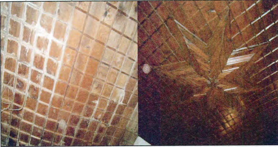
Şekil 3.136. Çitakari tekniğiyle yapılmış tavan bezemeleri (Seda Şimşek Tolacı çizim ve fotoğraf arşivi, 2005-2009)
