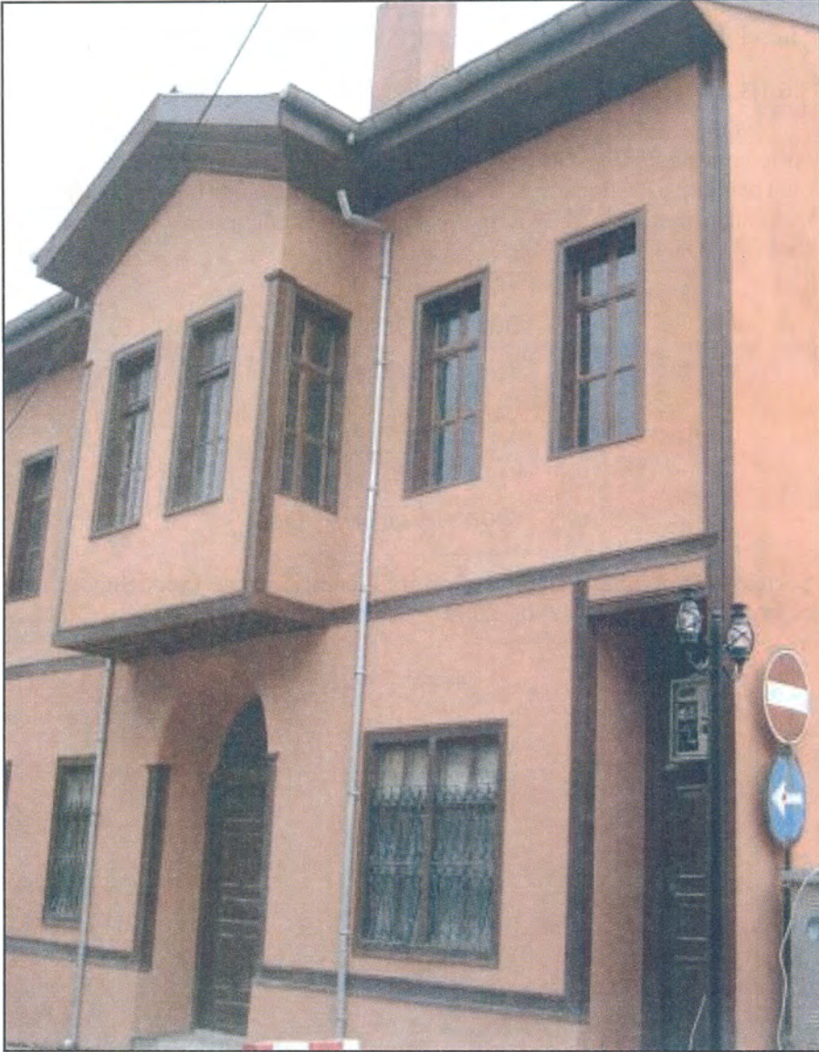
Şekil 3.48. Yapı tescil numarası 52 olan, orta sofalı yapının görünüşü (Seda Şimşek Tolacı çizim ve fotoğraf arşivi, 2005-2009)
