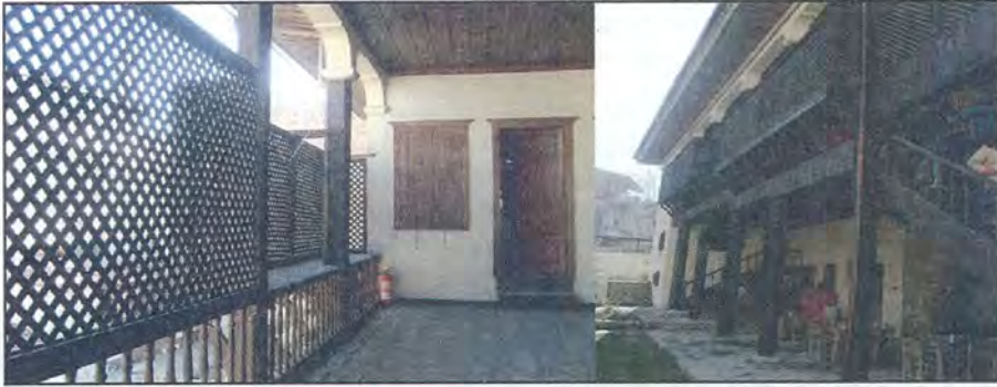
Şekil 3.63. Taş Oda'nın sofasında bulunan şahniler ve bu elemanların dış cepheye yansımaları (Seda Şimşek Tolacı çizim ve fotoğraf arşivi, 2005-2009)
