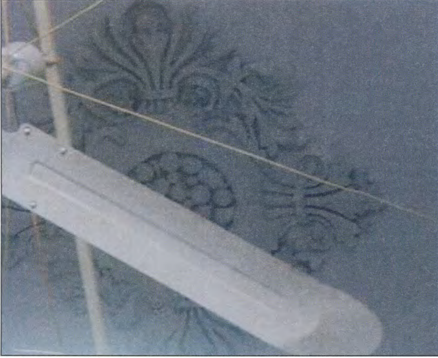
Şekil 2.34. Eski Belediye Caddesi No: 13 'te bulunan yapı tescil numarası 88 olan yapı (Seda Şimşek Tolacı çizim ve fotoğraf arşivi, 2005-2009)
