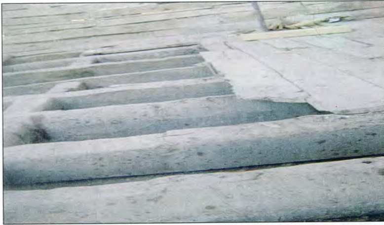
Şekil 3.159. Burdur Türk Evlerinde kullanılan döşemelerin kesiti(Seda Şimşek Tolacı çizim ve fotoğraf arşivi, 2005-2009)
