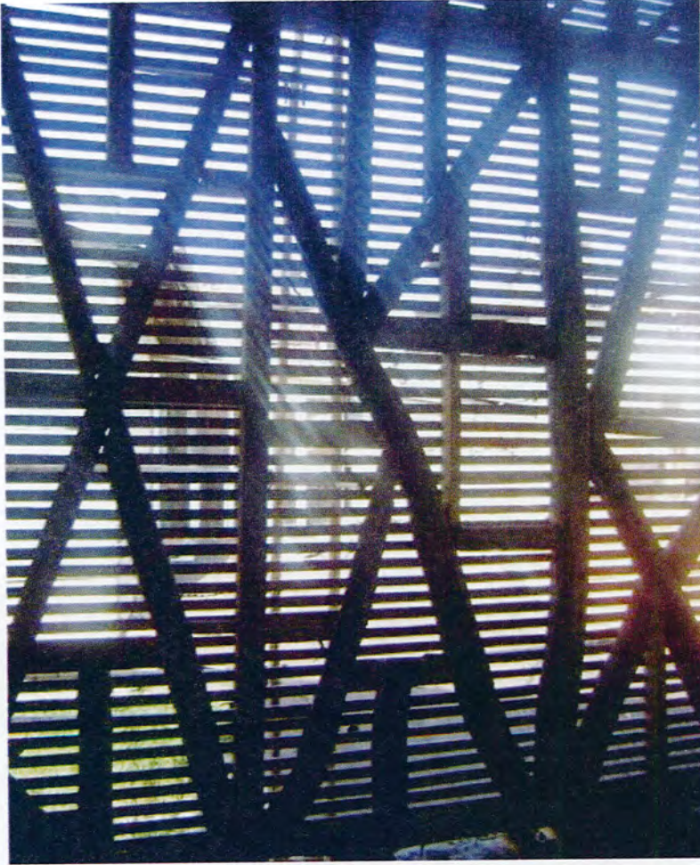
Şekil 3.156. Piribaşlar Evi'ndeki, ahşap karkas sistem içerisindeki yan elemanların kullanımı(Seda Şimşek Tolacı çizim ve fotoğraf arşivi, 2005-2009)
