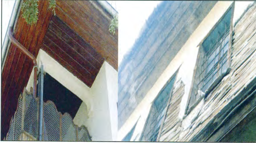
Şekil 3.121. Çatı saçaklarının altları ahşap malzeme ile kapatılan yapılara örnekler (Seda Şimşek Tolacı çizim ve fotoğraf arşivi, 2005-2009)
