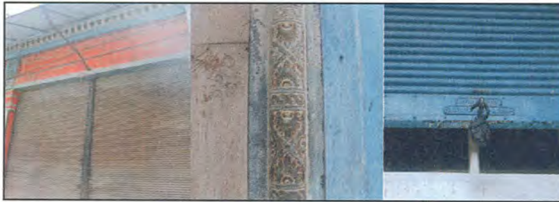
Şekil 2.30. Tarihi Ticari Merkez'de bulunan özgün kepenk ve kepenk elemanlarına örnekler (Seda Şimşek Tolacı çizim ve fotoğraf arşivi, 2005-2009)
