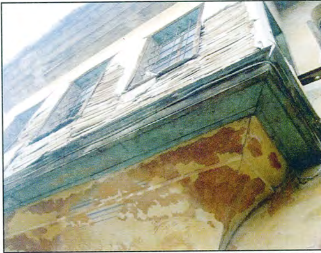
Şekil 3.107. Sarıoğlu Evi çıkmasının dolu payandası (Seda Şimşek Tolacı çizim ve fotoğraf arşivi, 2005-2009)
