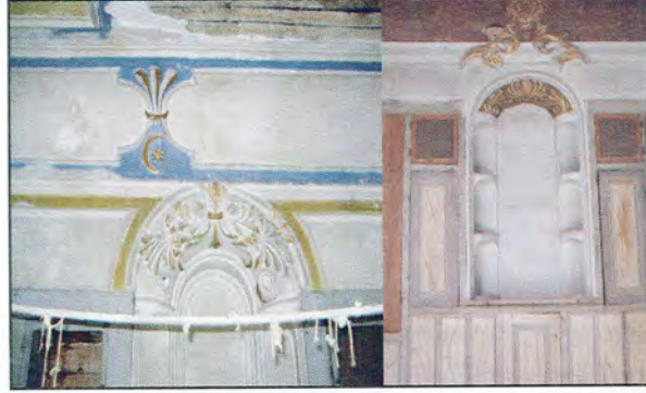
Şekil 3.149. Sarıoğlu Evi ve yapı tescil numarası 1 olan evdeki, alçı kabartma üzerine renklendirme yapılmış şerbetlik örnekleri(Burdur Kültür Ve Turizm Müdürlüğü fotoğraf arşivi, 2008)
