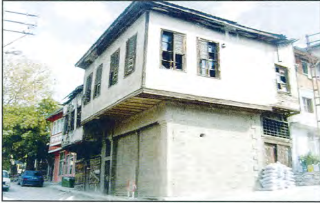
Şekil 3.104. Yağcı Kadirler Evi'ndeki çift yönlü devam eden çıkma (Çeşmedamı Mahallesi, Çeşmedamı Çıkmazı, No:1)(Seda Şimşek Tolacı çizim ve fotoğraf arşivi, 2005-2009)
