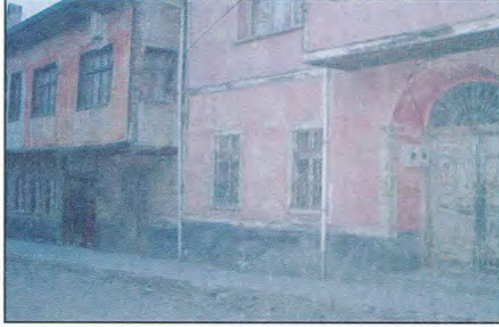
Şekil 3.110. Burdur Türk Evlerinde, hareketli kanatlı, düşey menteşeli, belirli bir oranı ve biçimi olmayan pencerelerden örnekler- Adres: Burç Mahallesi, Hükümet Caddesi, No: 17/A-19 (Seda Şimşek Tolacı çizim ve fotoğraf arşivi, 2005-2009)
