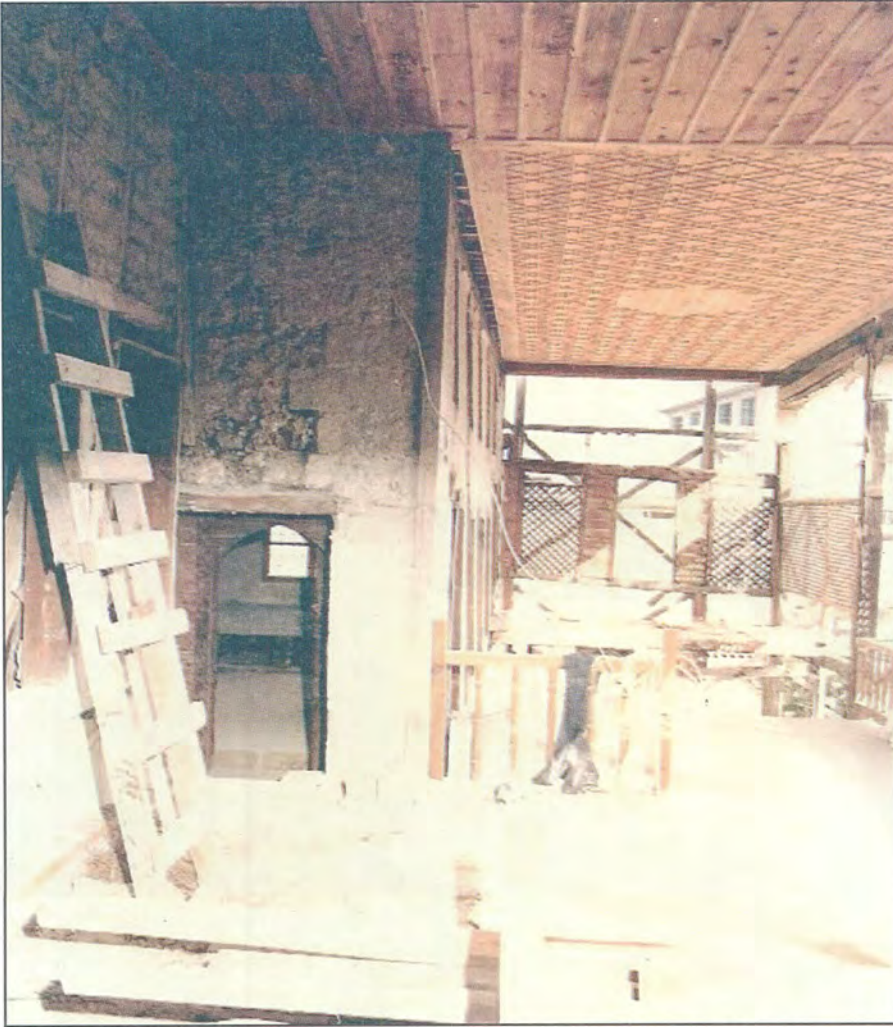
Şekil 3.61. Taş Oda'nın sofasını tamamen kaplayan kafesler (Yapının restorasyonu sürecinde çekilmiş foto-yapının özgün kafesleri) (Hasan Ali Göcen arşivi,2006)
