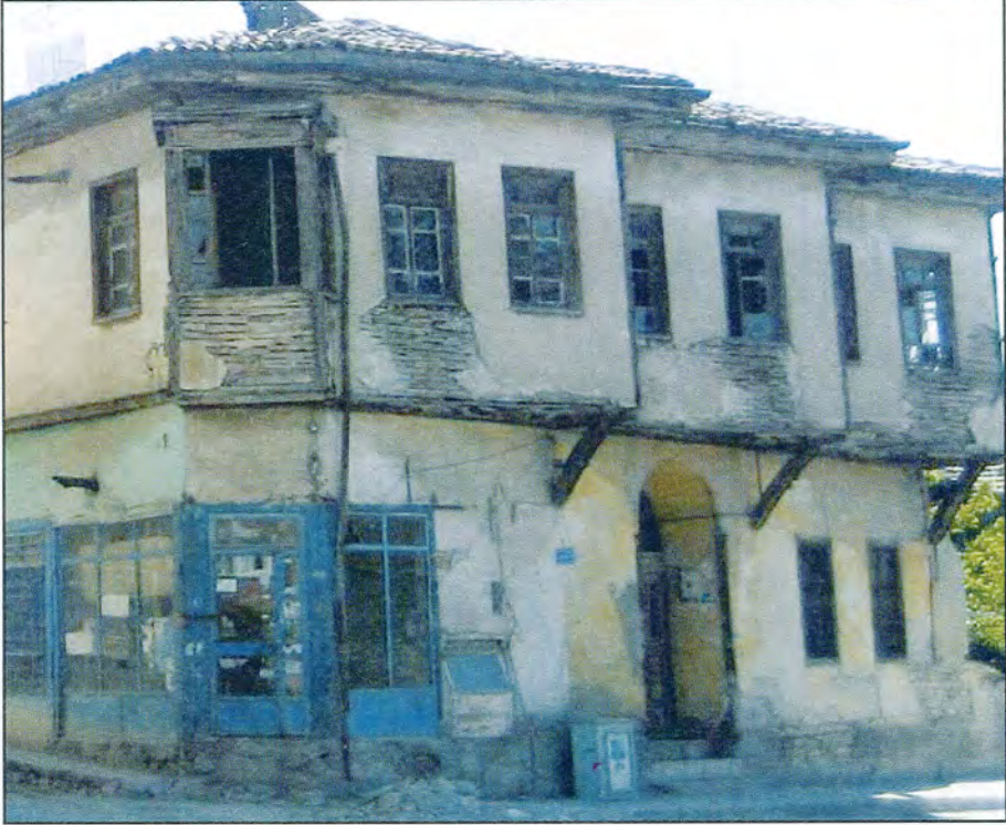
Şekil 3.106. Piribaş Evi köşe ve gönye çıkmasının görünümü (Seda Şimşek Tolacı çizim ve fotoğraf arşivi, 2005-2009)
