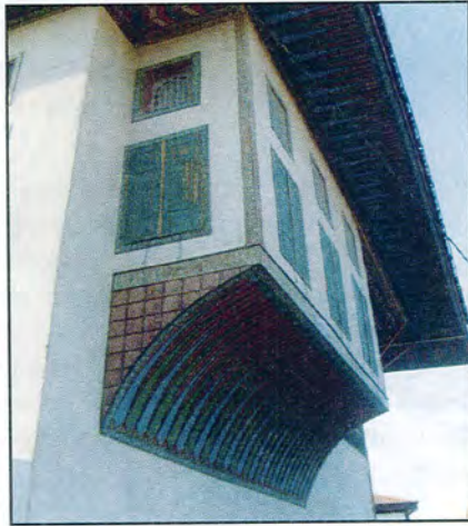
Şekil 3.107. Sarıoğlu Evi çıkmasının dolu payandası (Seda Şimşek Tolacı çizim ve fotoğraf arşivi, 2005-2009)
