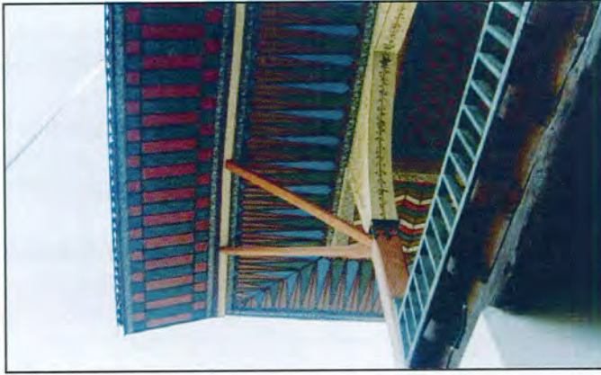
Şekil 3.122. Bakibey Konağı'nın geniş ve bezemeli çatı saçığı (Değirmenler Mahallesi, Divanbaba Caddesi) (Seda Şimşek Tolacı çizim ve fotoğraf arşivi, 2005-2009)
