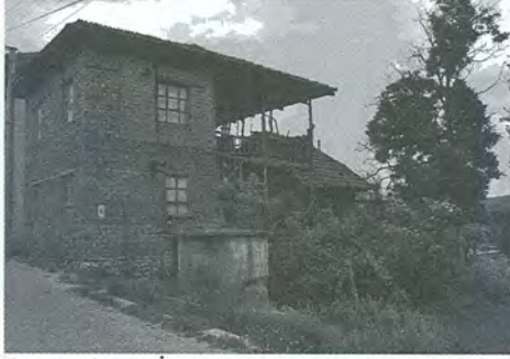
Fotoğraf 17: İki katlı ve kerpiç yapı malzemesi ile inşa edilmiş bir Ağlasun evi.
