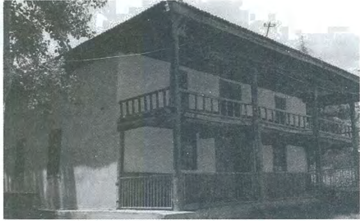
Resim 15- Yeşilova İlçesi Niyazlar Köyü – Köy Camisi (AEGM Arşivi)
