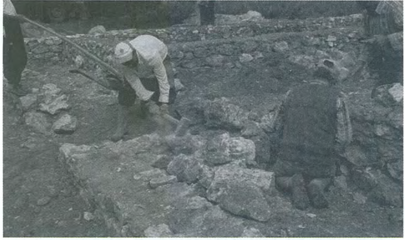
Resim 30- Gölhisar İlçesi İbecik Beldesi – İnşaat alanında çalışan ustalar (AEGM Arşivi)
