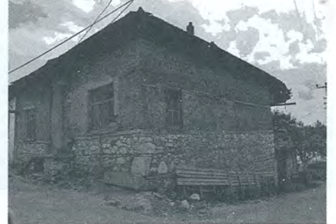
Fotoğraf 18: İlk katın bazen taş yapı malzemesi ile inşa edildiği konutlara da rastlanır.
