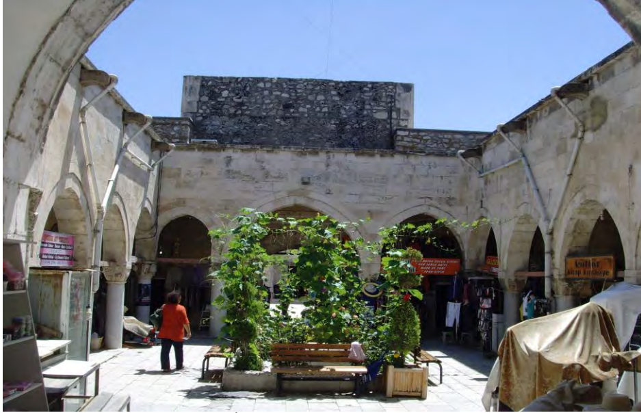
Eğirdir-Dündar Bey Medresesi İçerisinden Görünüm
