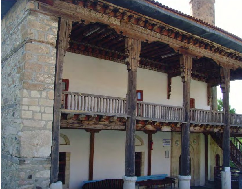
Çavdır Dengere Köyü Eski Camii
